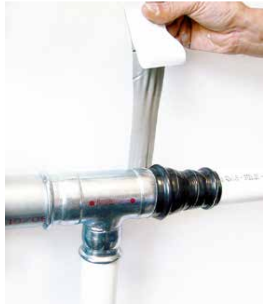
Fig. 35 - Beskyttelse af tilslutninger med butanoltape.
