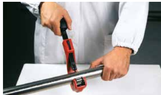
Fig. 25 - Tilskæring af rør
