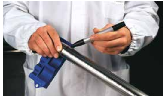
Fig. 28 - Markering af indstiksdybde
