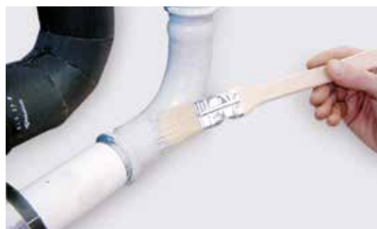
Fig. 34 - Lakering af rør og tilslutninger med grunder.
