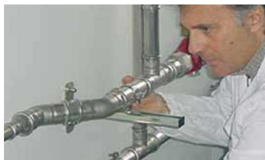
Fig. 33 - Kontrol af pressamling
